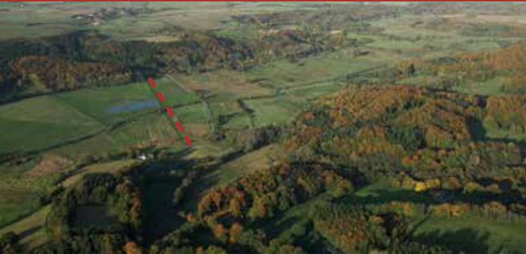
Die Brücke im Bachtal. Ein kleiner Damm gibt die Lage der Brücke an. Foto: Jan Kofoed Winter
